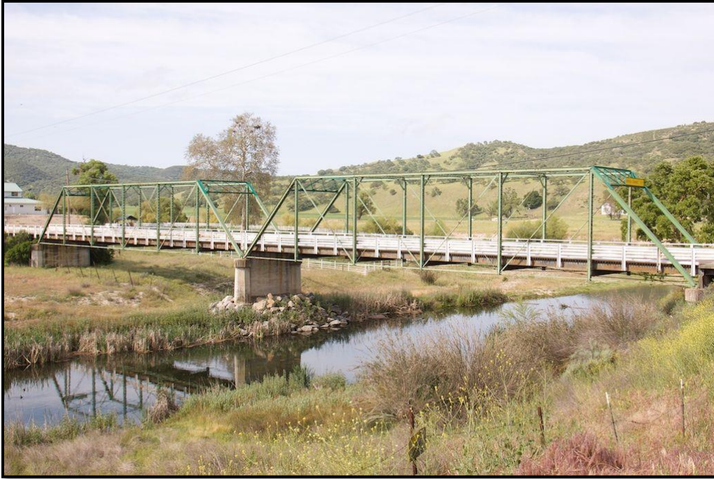
Existing Nacimiento Road bridge to be replaced
